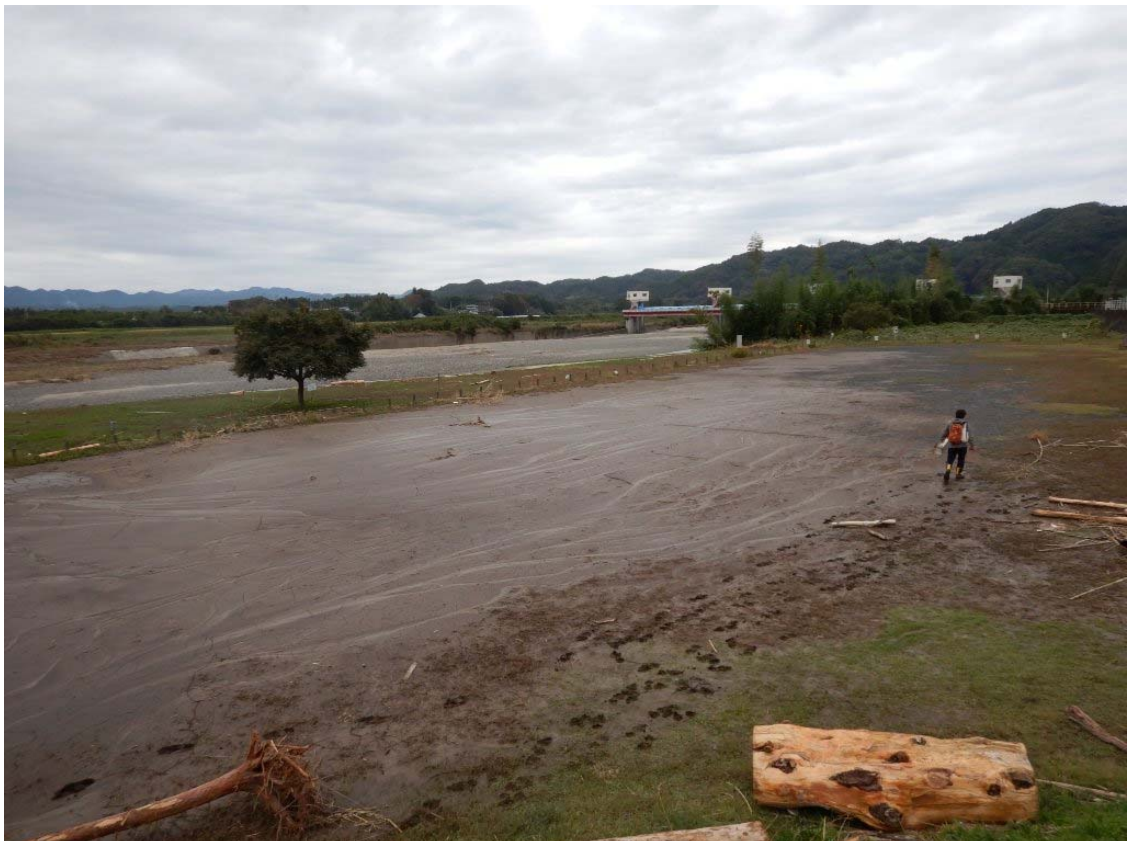
駐車場部の広範囲に土砂が堆積。土砂量の計測を実施。
