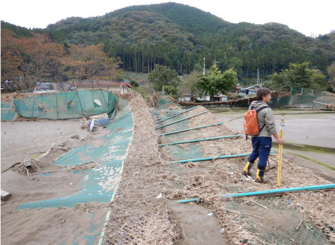
テニスコートに土砂が堆積。土砂量の計測を実施。
