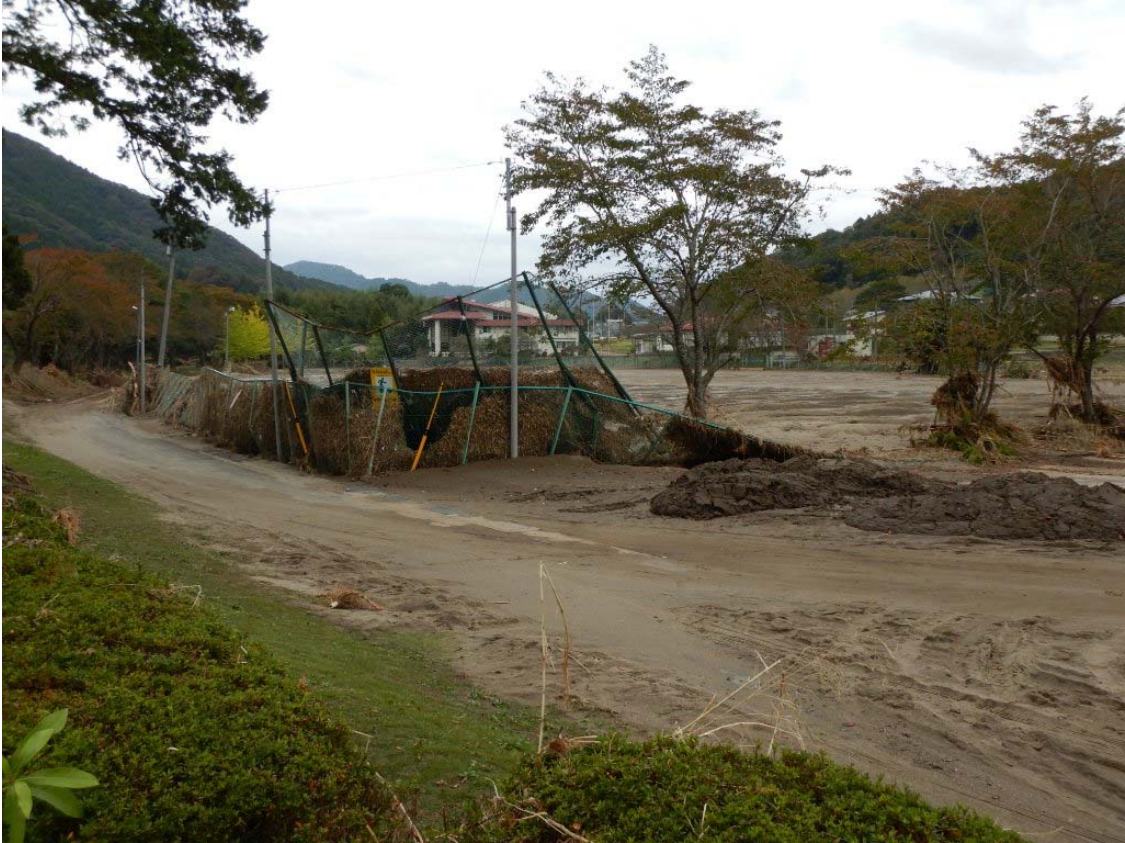
多目的グラウンドに土砂が堆積。土砂量の計測を実施。
